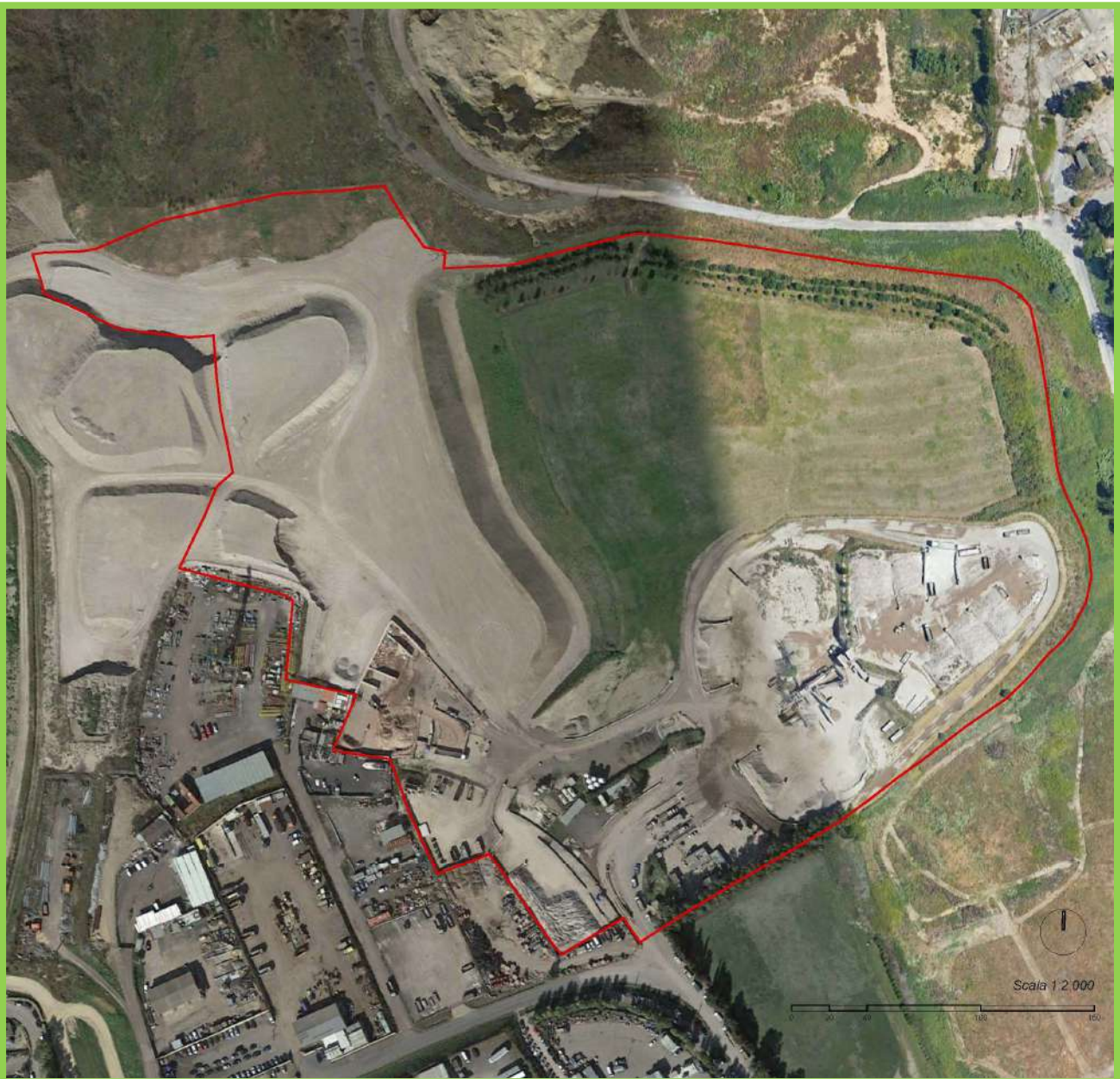
Figura 2 – L'area di attività della RIME 1 (contornato in rosso) – Inquadramento territoriale su Foto Aerea.
